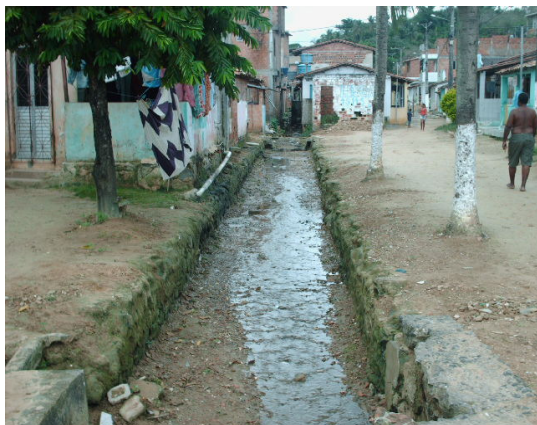
Figura 8. Esgoto a 'céu aberto' próximo ao Cemitério de Santana – Ilha de Maré – Salvador-BA..
