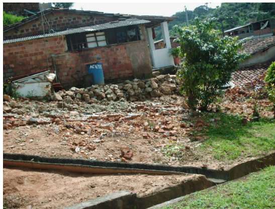
Figura 9. Destroços do muro e residências próximas ao cemitério de Santana – Ilha de Maré – Salvador-BA.
