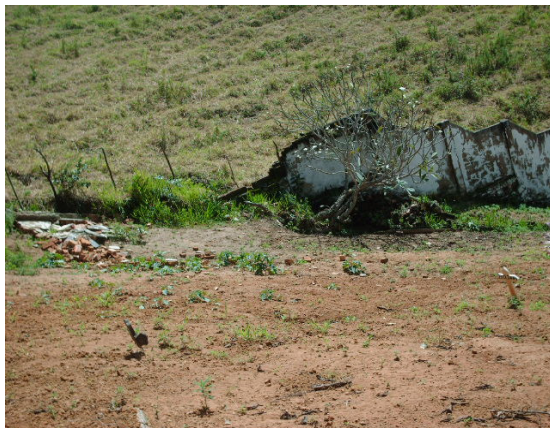
Figura 6. Muro danificado no cemitério de Santana. Ilha de Maré. Salvador-BA.
